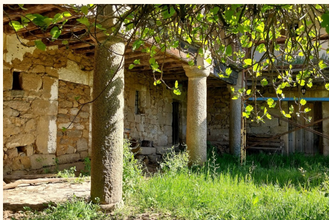
Galería de la casona de la Abañeza. Fotogr.: MSF.
