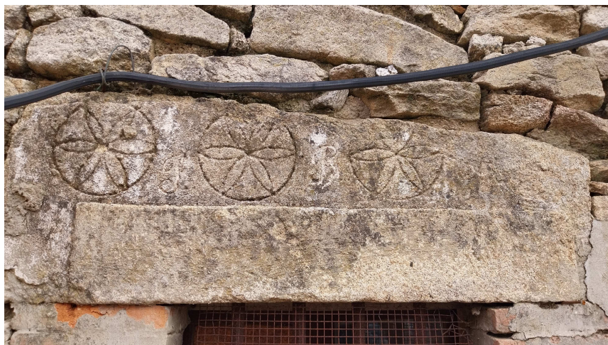
Dintel de la ventana con tres símbolos grabados del germen de vida. Fotogr. MSF.
